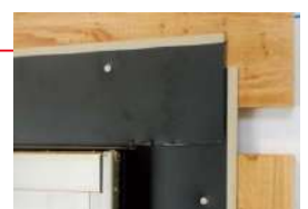
サッシ横に取り付けた部材の上に重なるように施工
