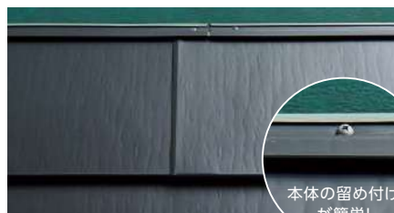
施工イメージ(UP)
