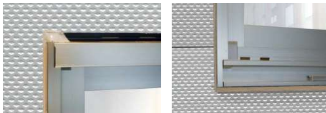
サイディングとサッシの隙間が小さくなるように施工
