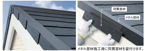
メタル部材施工後に同質部材を留付けます。
